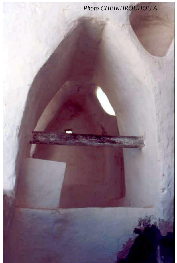
Photo 7. Matmata, puits creusé au préalable dans une maison troglodytique.
