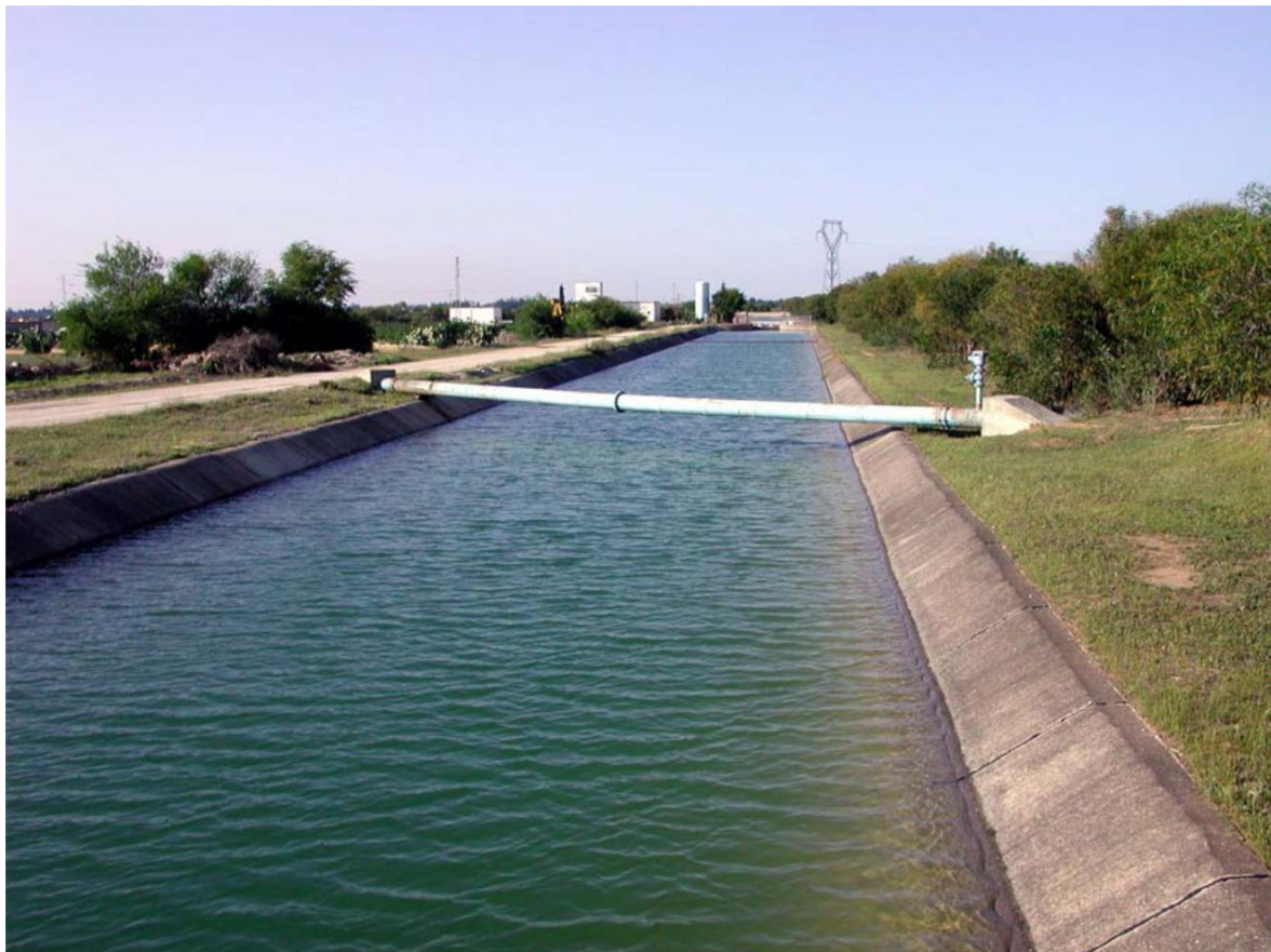
Canal de transfert des eaux du Nord vers le Cap Bon, le Sahel et Sfax.
