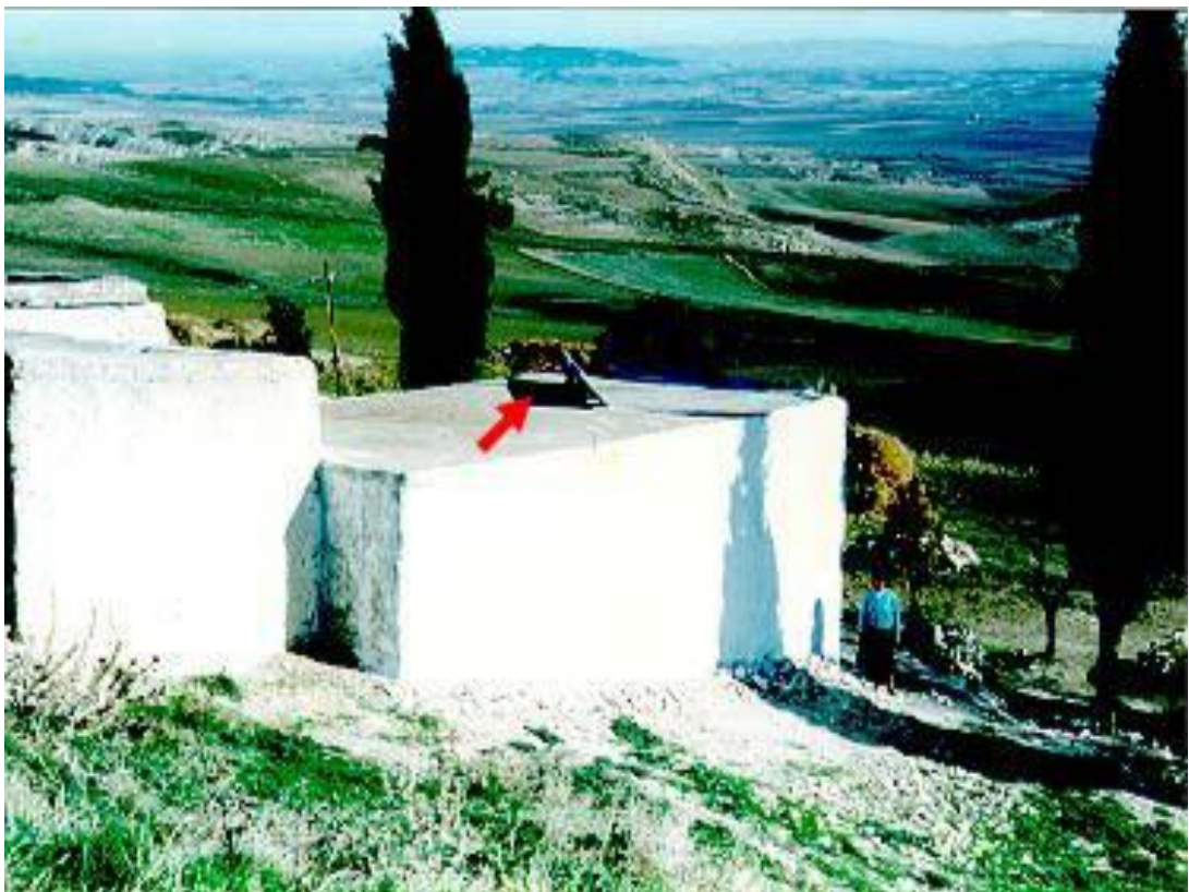
Photo 4. Utilisation de l'énergie solaire photo-voltaïque.
